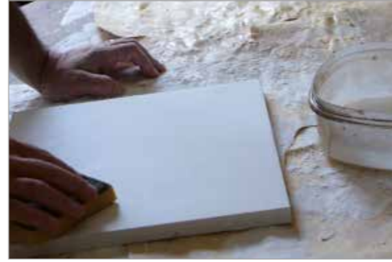
Levigatura, con spugna inumidita, della superficie del gesso
